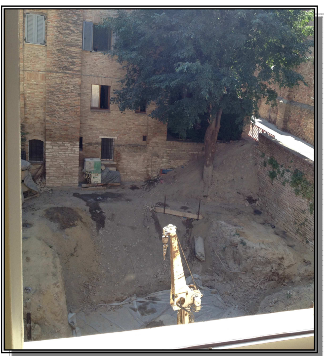
I lavori di scavo e consolidamento perimentrale
